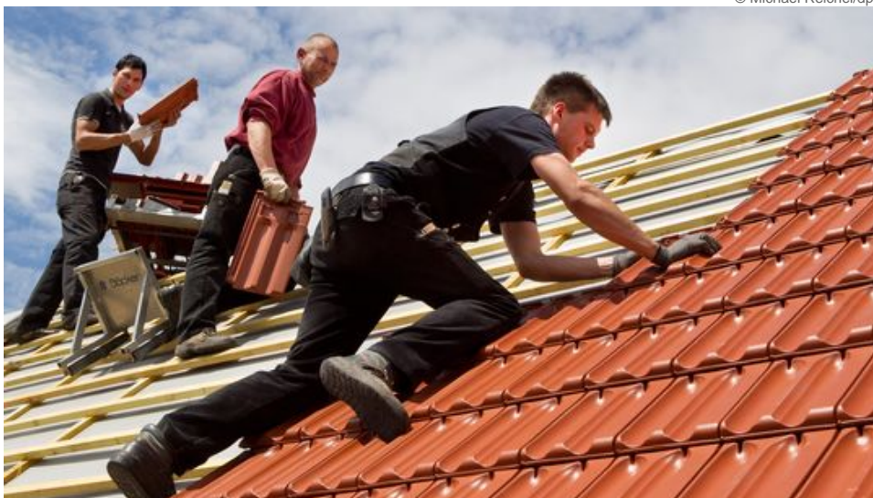
Dachdecker in Thüringen
